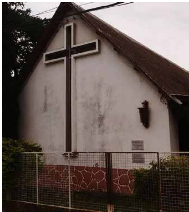
Congregación Barranqueras, Avenida San Martín 1190, Ciudad de Barranqueras - Chaco.
